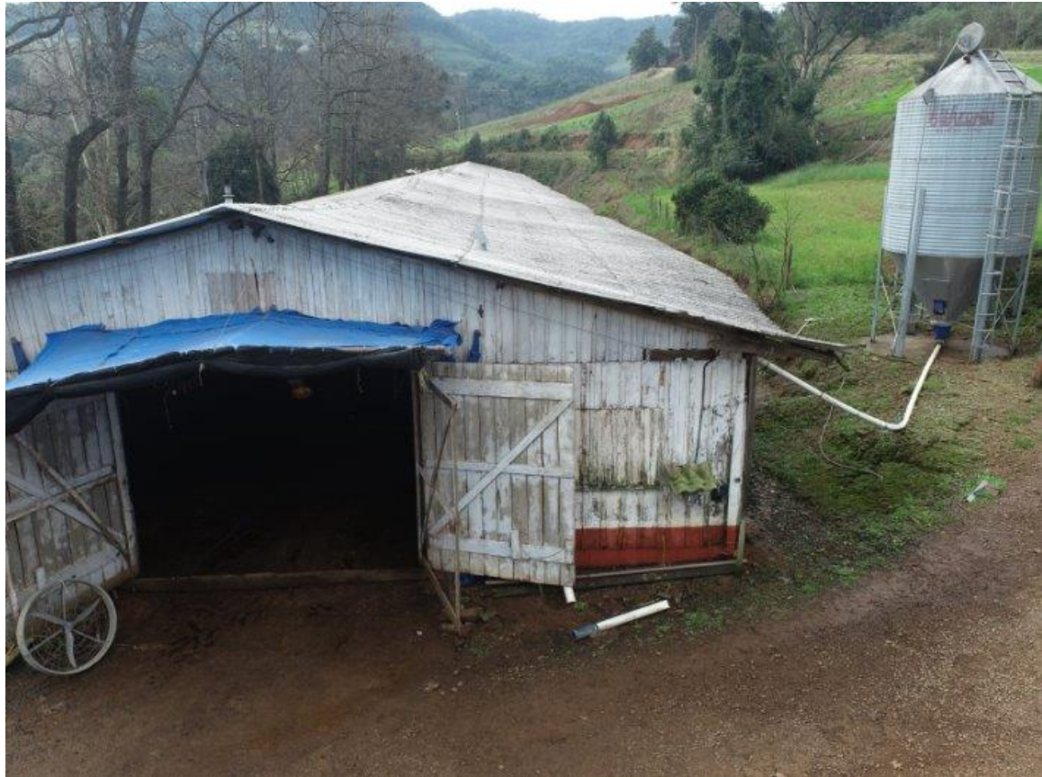
Saneamento, limpeza e desinfecção Sanitation, cleaning and disinfection
